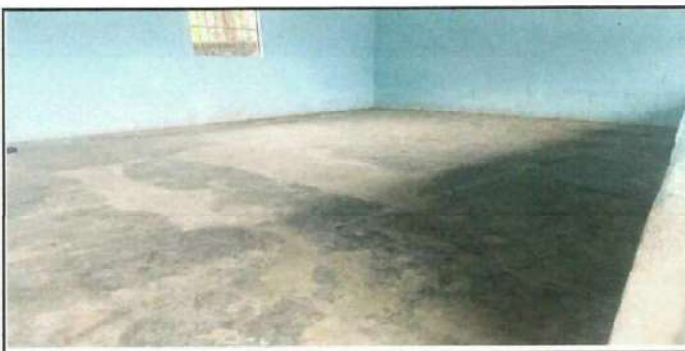
Foto 5: Se observa la necesidad de la reparacion de piso de torta de concreto.
