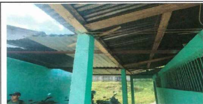
Foto 3: Se observa la necesidad de la sustitucion de la estructura de soporte
