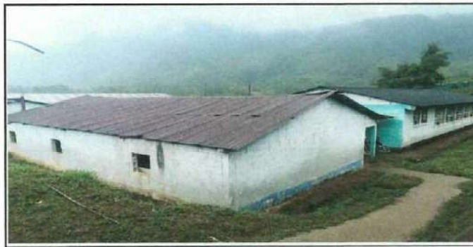
Foto 6: Se observa la necesidad de la sustitucion de lamina, por lamina troquelada
